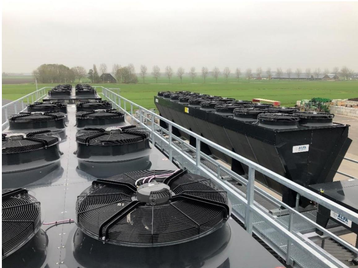
LU-VE Group ha fornito soluzioni ad ammoniaca per le pompe di calore per un impianto da 500kW impiegato per lo stoccaggio di bulbi di fiori in Paesi Bassi. Il sistema permette sia di raffreddare i bulbi per fermare la crescita delle radici, sia riscalarli affinché non crescano funghi dannosi.
