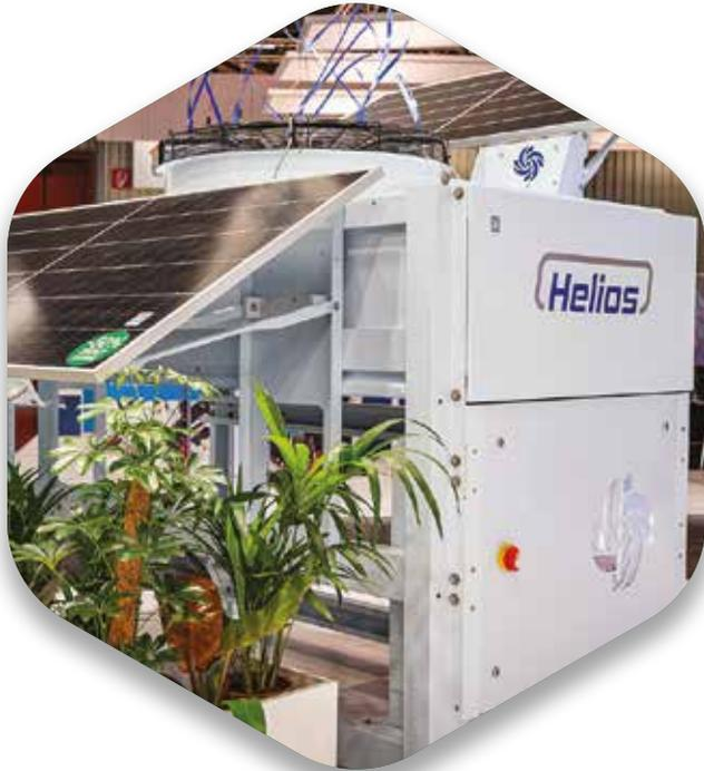
Nel corso del 2022, è stato introdotto il nuovo **gas cooler a CO<sub>2</sub> con pannelli solari** in collaborazione con il Laboratory of Energy Conversion and Storage (LabX) del Politecnico di Milano.
